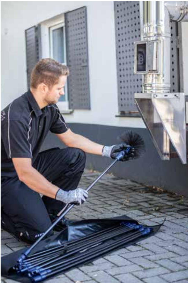
Par un simple clips, vous fixez la brosse sur la canne. Les outils non utilisés sont placés sur le sac ouvert afin que la zone de travail reste propre.
