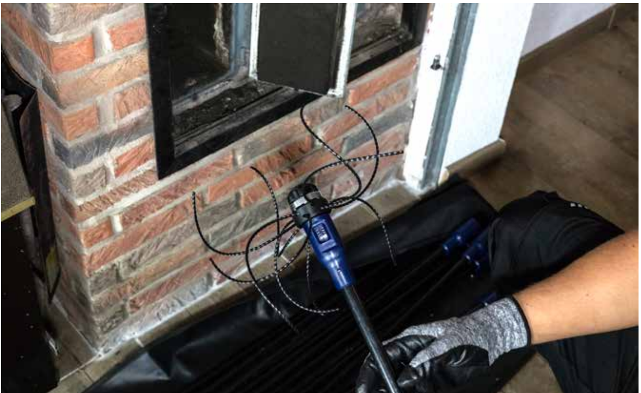
Il est également possible d'utiliser la tête rotative avec fils de coupe. Pour un nettoyage particulièrement intensif, vous pouvez tourner la canne à l'aide d'une perceuse.
