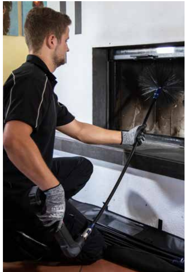
En utilisant votre perceuse, vous pouvez faire tourner une brosse ou autre accessoire. Ainsi même le bistre ne sera plus un problème pour vous.
